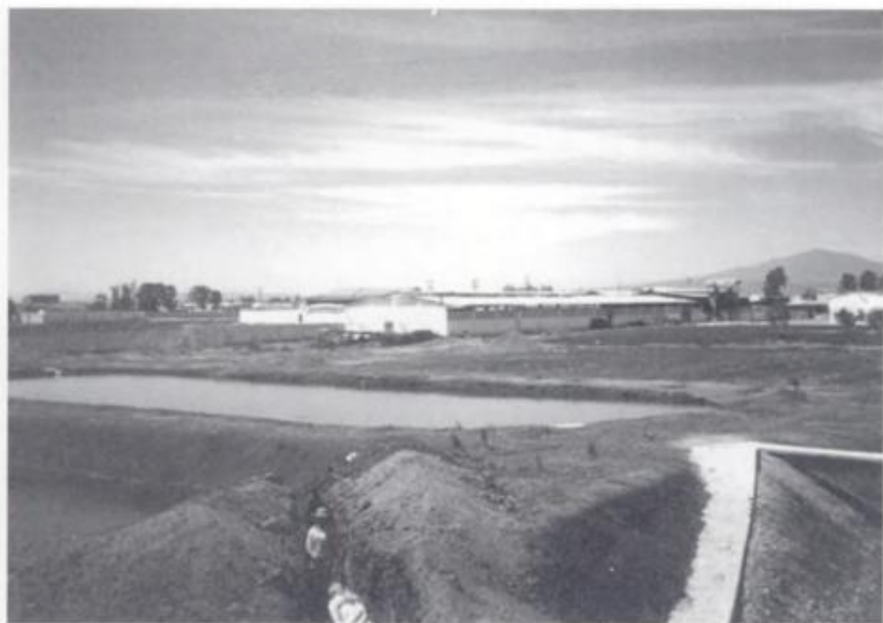
Laguna de oxidación
