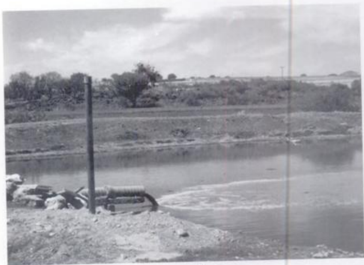
Laguna de oxidación
